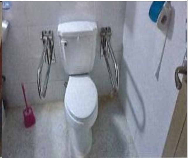
비데 및 안전손잡이 설치
